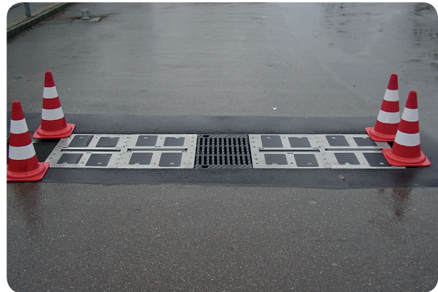
Bild 4: Je nach Anforderungen können bis zu 4 Messköpfe in Schächte oder U-Kanäle in die Fahrbahn eingelassen werden.
