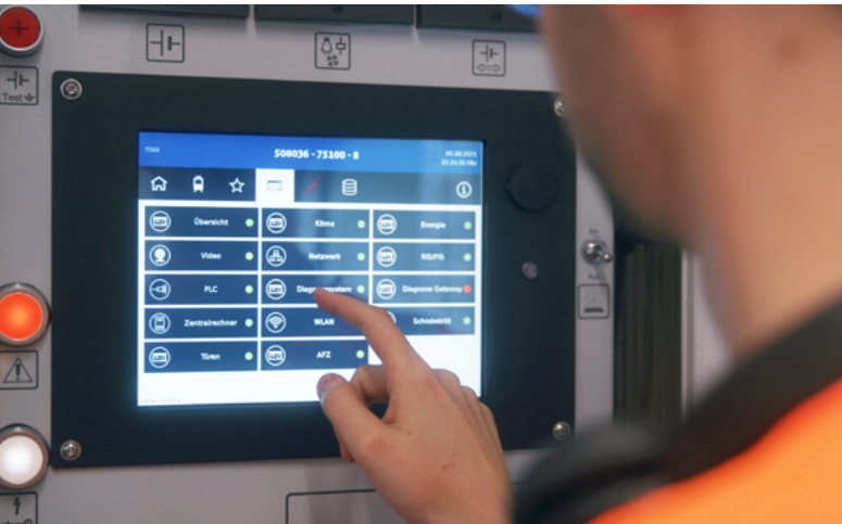
// DB Mitarbeiter prüft die Diagnose
